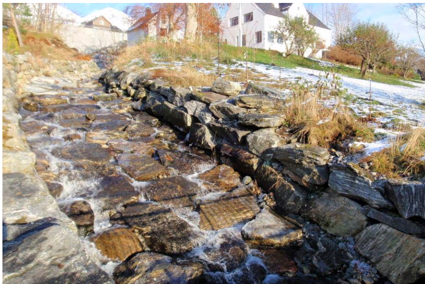
Figur 69 Bekk plastret med stor stein
