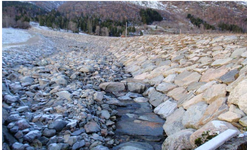
Figur 70 Plastret elveløp (elva har lagt igjen massene i bunnen)
