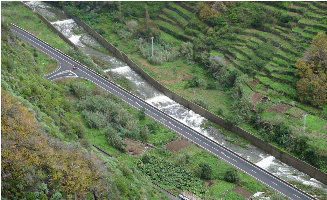
Figur 27 Stabilisering med betongvegger og -terskler (Ribeira Brava, Madeira)
