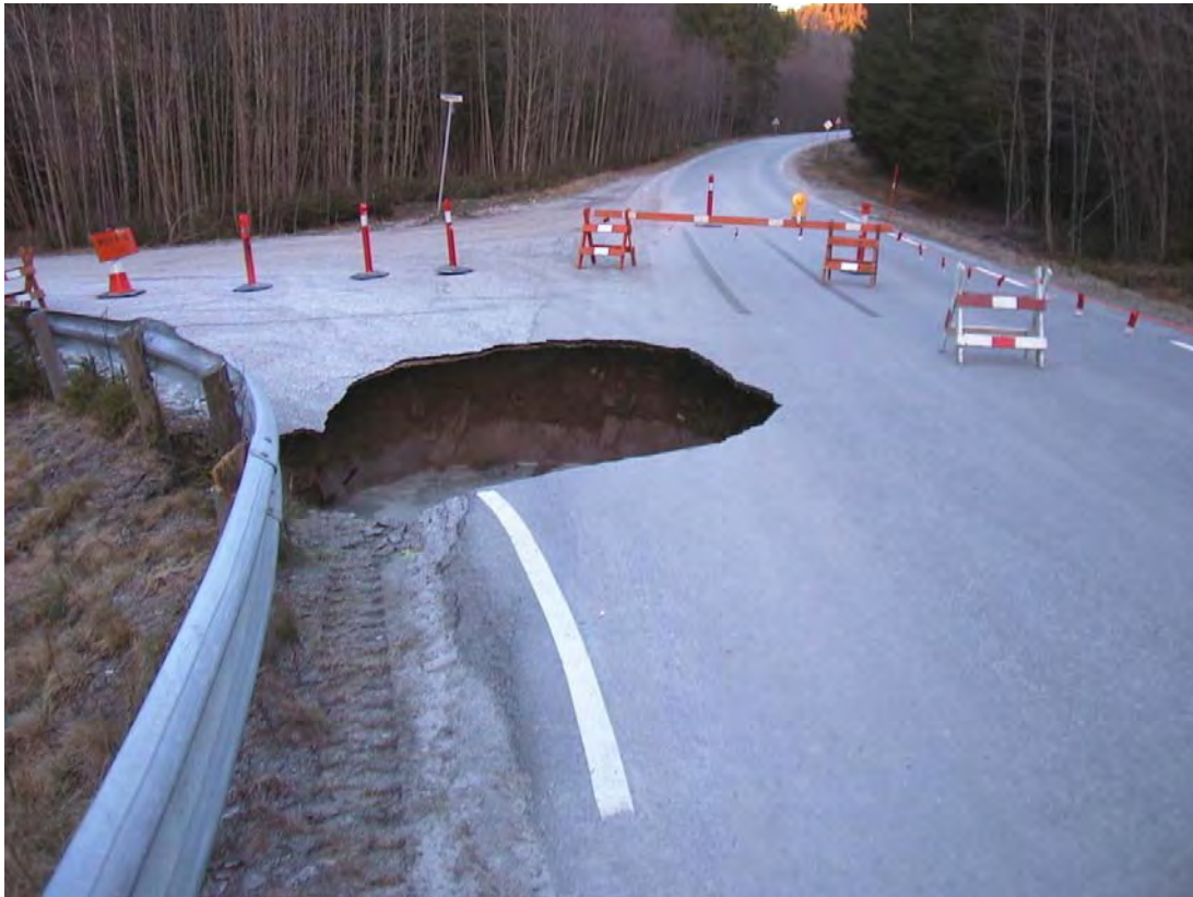
Figur 14.23 Utvasket vegbane etter endret artesiske trykk – Valebø, Telemark (foto: B.K. Dolva)
