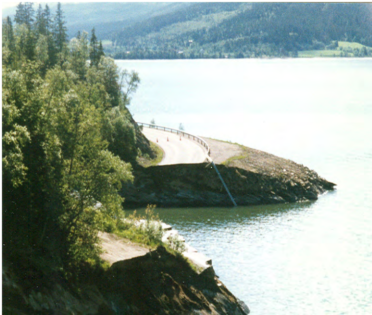
Figur 1.1 Bilde av ras på E6 ved Finneidfjord, Nordland
