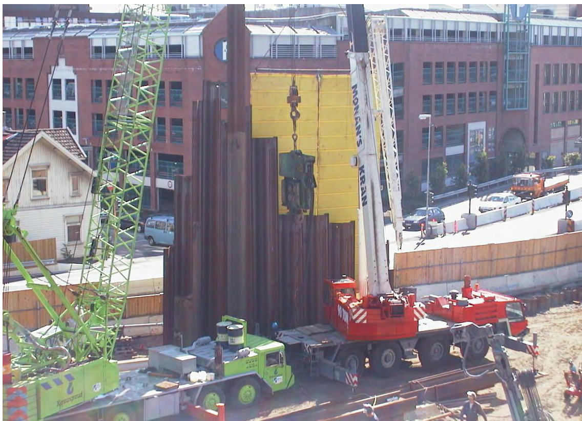
Figur 18.4 Støyskjermende tiltak E 18 Kristiansand, Banehagen tunnelportal
